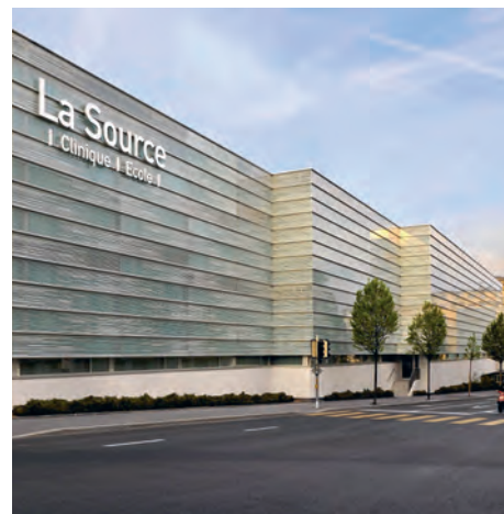
Situé à l'Avenue Alexandre-Vinet, à Lausanne, l'Institut et Haute École de la Santé La Source inaugure de nouveaux locaux dans le Palais de Beaulieu en 2018
